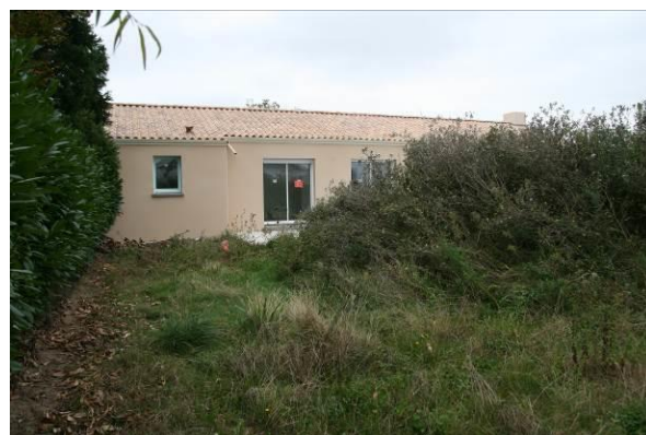
Pavillon en cours de construction
